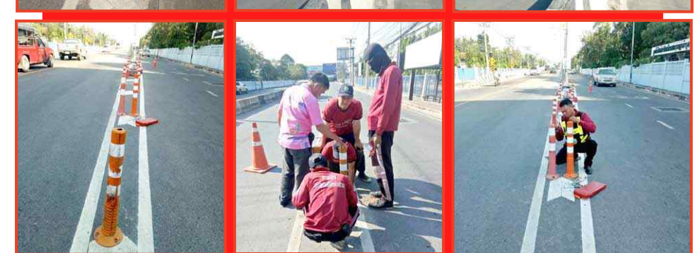
เปลี่ยนแบตเตอรี่หลอดไฟจราจร และซ่อมเสาข้างที่ชำรุด บริเวณสะพานต่างระดับถนนบ้านสวน - หองช้างคอง
